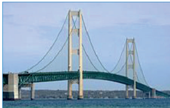
Fig. 4 – Ponte sul Mackinac del 1957 – Opera di Steinman
