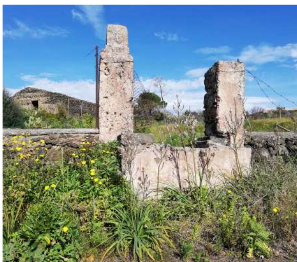
Antica cisterna in contrada Pampio datata 1754. Comunemente chiamata Cisternazza in relazione alle sue dimensioni
